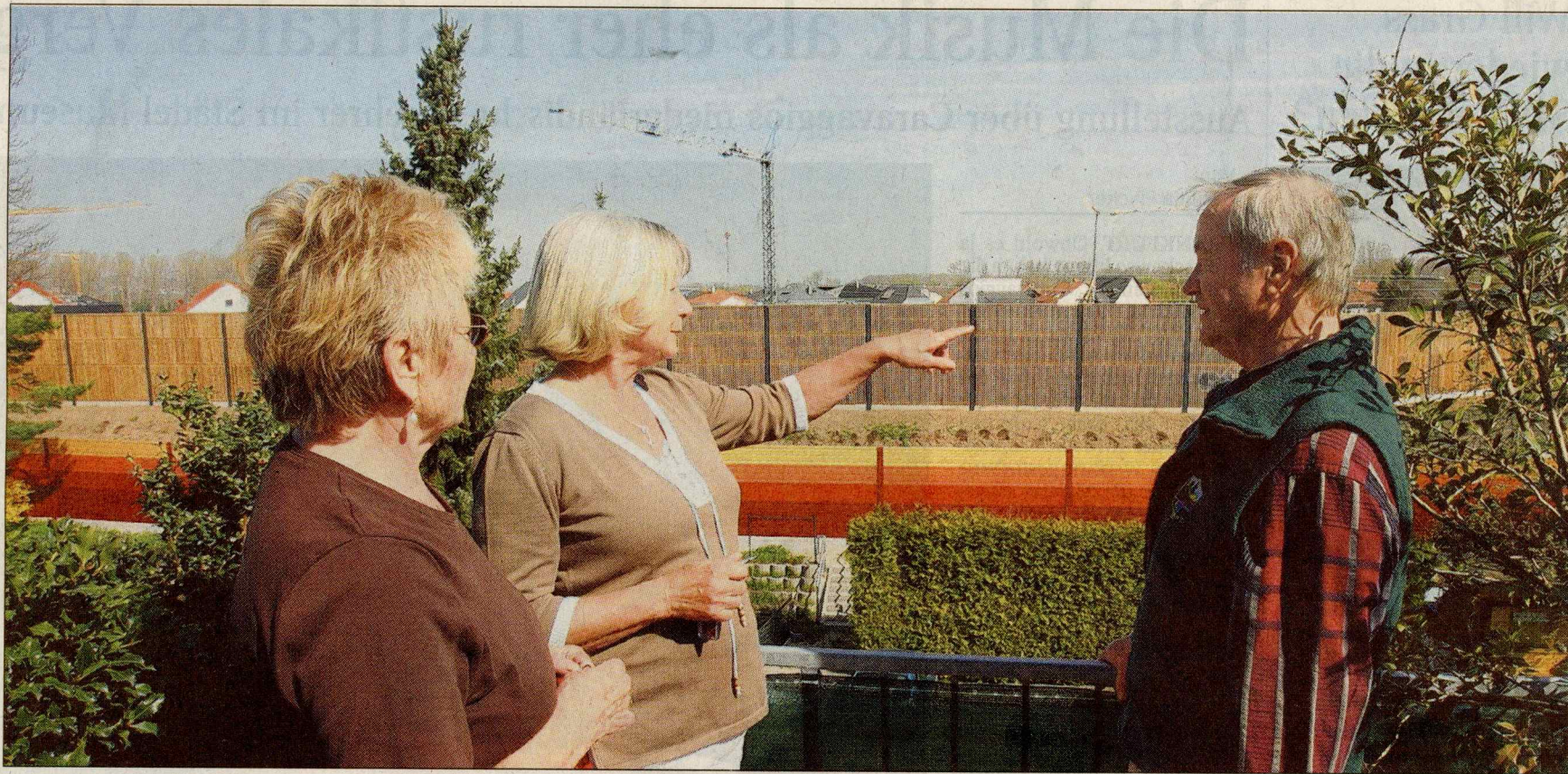
Anwohner der Straße „In den Haferwiesen“ ärgern sich über den fast neun Meter hohe neue Lärmschutzwall, der die Neubaugebiete jenseits der Gleise vor dem Bahnlärm schützen soll. Davor ist die ältere farbige Lärmschutzwand zu sehen, die die vor 1974 entstandene Bebauung abschirmt. Foto: hbz / Jörg Henkel
